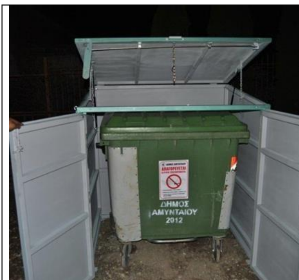
Εικόνα 17: Κατασκευαστικές λεπτομέρειες του ενισχυμένου κελύφους
