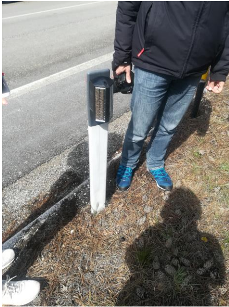
Εικόνα 3. Σύστημα ήχου τοποθετημένο σε κολονάκι οδού για την αποτροπή διέλευσης μεγάλων θηλαστικών.
