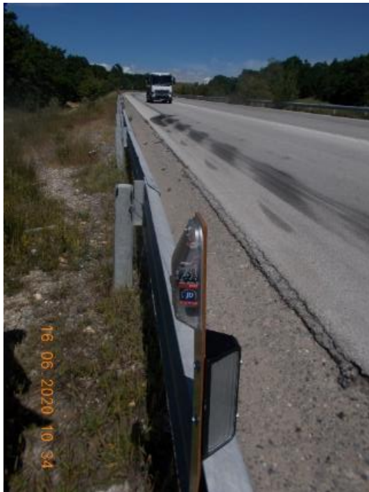
Εικόνα 4: Οπτικο-ακουστικοί απωθητές και ανακλαστήρες φωτός, «Εικονικός» στην Νέα Εθνική Οδό και στην Παλιά Εθνική Οδό Αμυνταίου-Φλώρινας.
