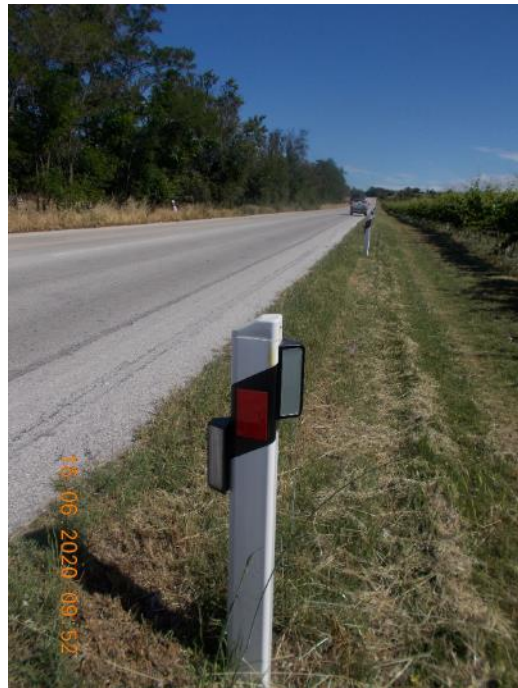
Εικόνα 4: Οπτικο-ακουστικοί απωθητές και ανακλαστήρες φωτός, «Εικονικός» στην Νέα Εθνική Οδό και στην Παλιά Εθνική Οδό Αμυνταίου-Φλώρινας.
