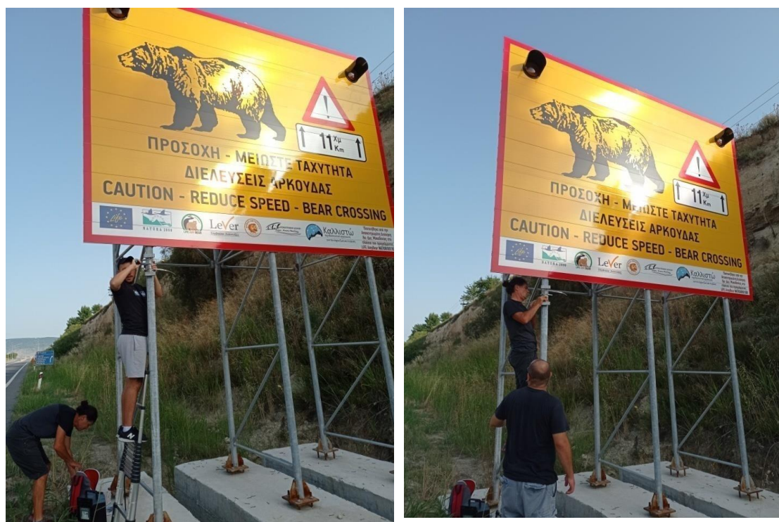
Εικόνα 33 & Εικόνα 34: Διαδικασία τοποθέτησης ραντάρ στην μεγάλη πινακίδα 3x4m
