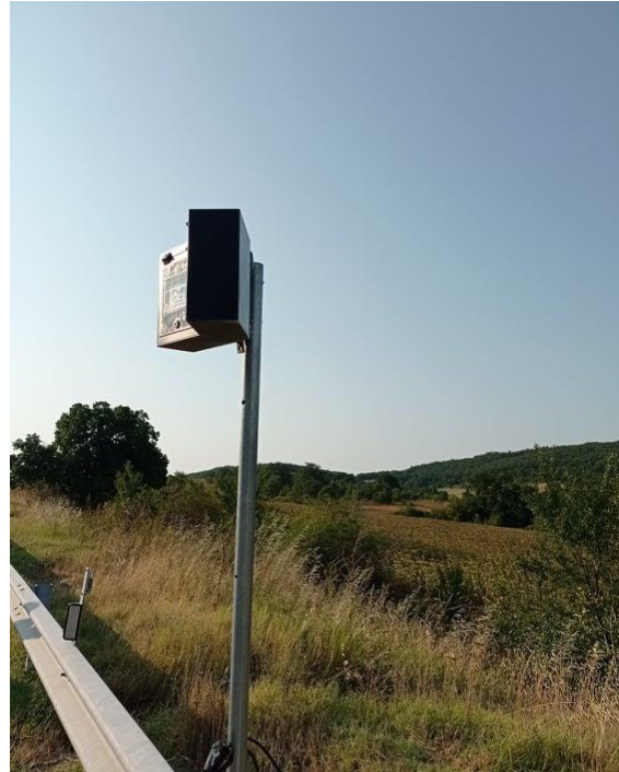
Εικόνα 36: Τοποθετημένο ραντάρ στην Νέα Εθνική Οδό Αμυνταίου-Φλώρινας ~250m πριν τη πινακίδα 120x80cm
