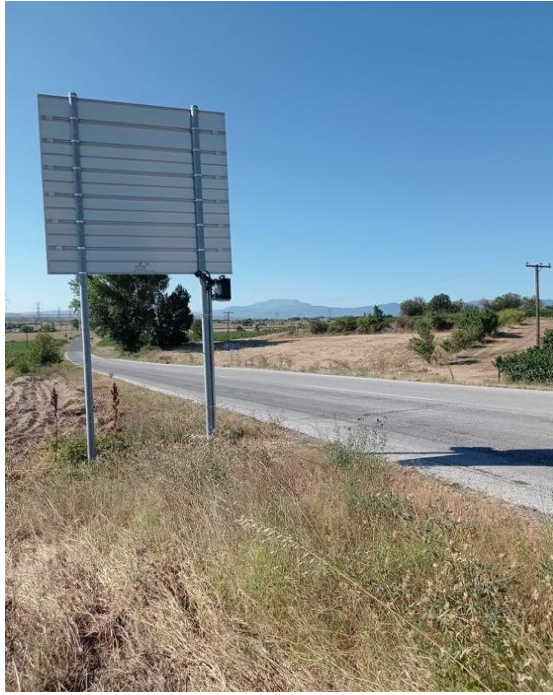
Εικόνα 35: Τοποθετημένο ραντάρ πάνω στην πινακίδα 2x2 m στην Παλαιά Εθνική οδό Αμυνταίου-Φλώρινας
