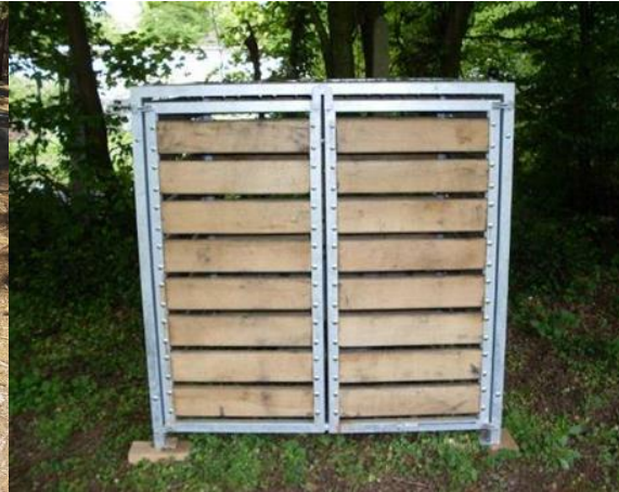
Εικόνα A-4: Ξύλινο Κέλυφος με μεταλλικό πλαίσιο για την τοποθέτηση πλαστικών κάδων (Σλοβενία, LIFE DINALP BEAR)
