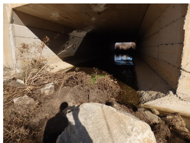
Εικόνα 100. Οχετός διαστάσεων 13X40 στη θέση 283801-4523280. Ανάπτυξη βλάστησης στις εισόδους, παρουσία φερτών υλικών, σκουπιδιών και στάσιμου νερού μειώνουν πολύ την ορατότητα και την δυνατότητα πρόσβασης και χρήσης από την πανίδα.
