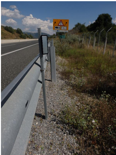
Εικόνα 84. Σωστή στήριξη μεταλλικού πασσάλου στο στηθαίο του ΚΑ45 με αποτέλεσμα την εγκατάσταση του ανακλαστήρα παράλληλα προς το κατάστρωμα του δρόμου.
