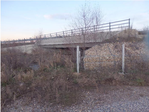
Εικόνα 99 Οχετός διαστάσεων 15X40 στη θέση 283485-4524070. Ανάπτυξη βλάστησης στην είσοδο και πολύ χαμηλό ύψος λόγω πλήρωσης με φερτά υλικά
