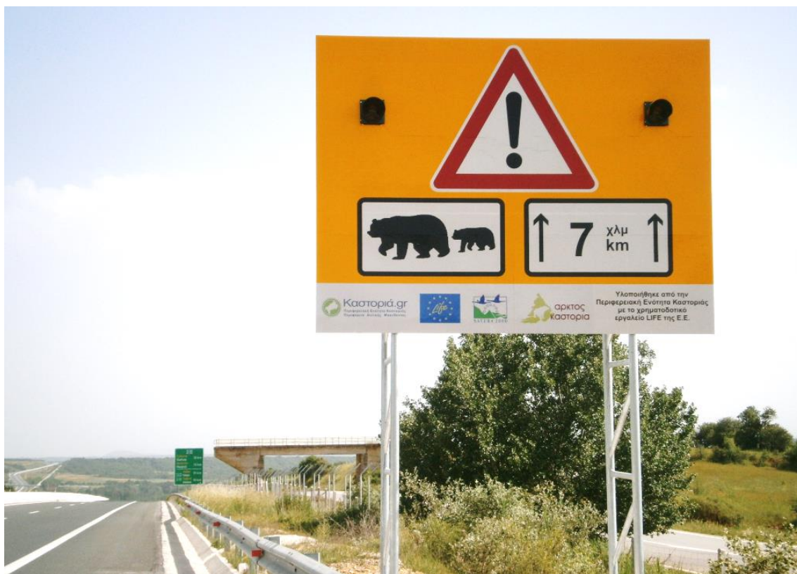
Εικόνα 69. Πινακίδα Αναγγελίας Κινδύνου διέλευσης ατόμων αρκούδας με αναλάμποντες φανούς στο τμήμα ΚΑ.45 της Εγνατίας Οδού.
