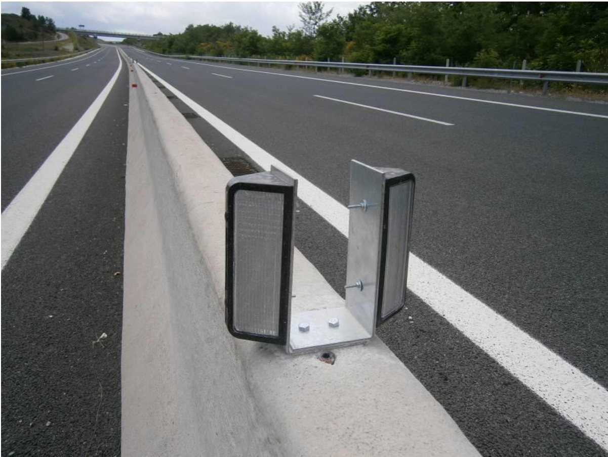
Εικόνα 79. Τοποθέτηση διπλών ανακλαστήρων στο ενδιάμεσο Jersey στον αυτοκινητόδρομο ΚΑ45 στο νομό Καστοριάς με την χρήση δυο ειδικών στηριγμάτων με δέσμη ανάκλασης εντός καταστρώματος του αυτοκινητόδρομου.
