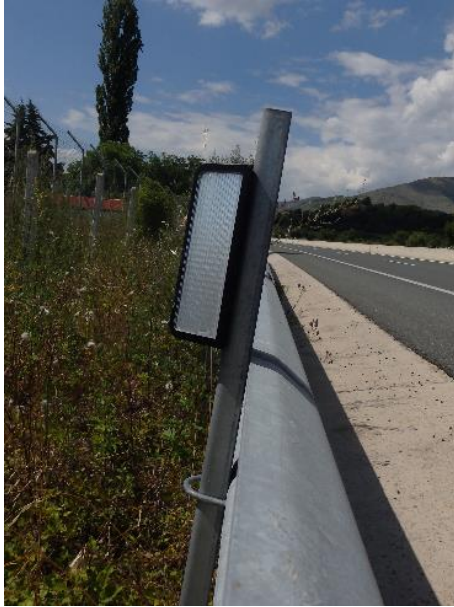
Εικόνα 83. Μη ικανοποιητική στήριξη μεταλλικού πασσάλου στο στηθαίο του ΚΑ45 με αποτέλεσμα την εγκατάσταση του ανακλαστήρα με κλίση προς το κατάστρωμα του δρόμου (περιορισμένη λειτουργικότητα).
