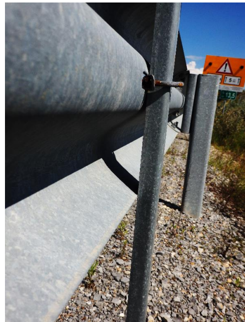
Εικόνα 84. Σωστή στήριξη μεταλλικού πασσάλου στο στηθαίο του ΚΑ45 με αποτέλεσμα την εγκατάσταση του ανακλαστήρα παράλληλα προς το κατάστρωμα του δρόμου.
