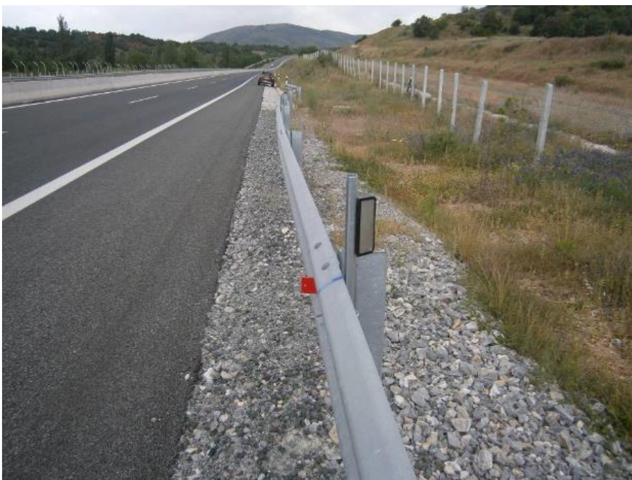
Εικόνα 81. Τοποθέτηση ανακλαστήρων στο πλαϊνό στηθαίο του ΚΑ45 σε μεταλλικούς πασσάλους με κατεύθυνση δέσμης ανάκλασης εκτός καταστρώματος
