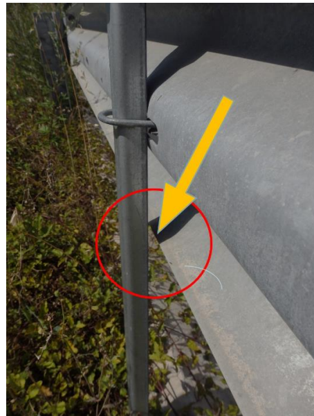
Εικόνα 83. Μη ικανοποιητική στήριξη μεταλλικού πασσάλου στο στηθαίο του ΚΑ45 με αποτέλεσμα την εγκατάσταση του ανακλαστήρα με κλίση προς το κατάστρωμα του δρόμου (περιορισμένη λειτουργικότητα).
