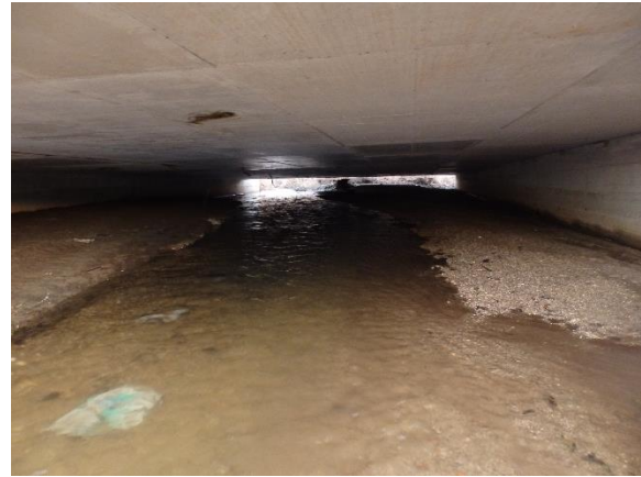
Εικόνα 99 Οχετός διαστάσεων 15X40 στη θέση 283485-4524070. Ανάπτυξη βλάστησης στην είσοδο και πολύ χαμηλό ύψος λόγω πλήρωσης με φερτά υλικά
